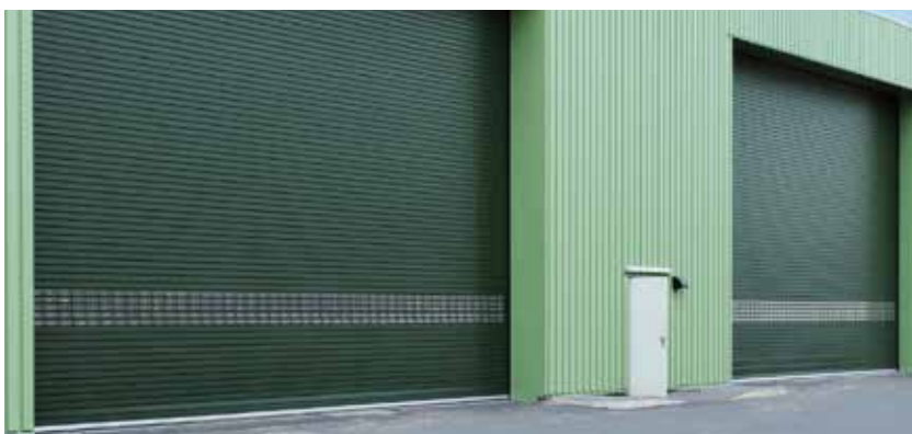
Fermeture de hall dans une entreprise industrielle
