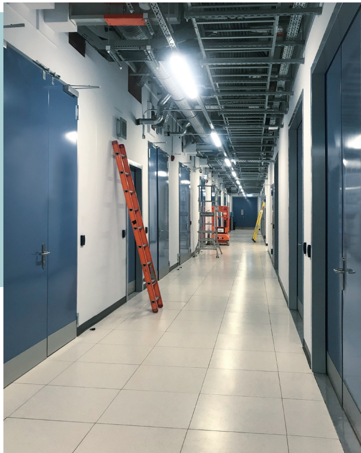
In datacenters worden voornamelijk 2-vleugelige dw 62 deuren in grote afmetingen (3 x 3 meter) gebruikt.
