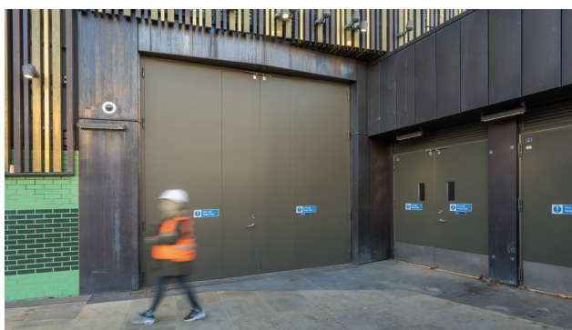
Anfertigung ganz nach Maß: Neben der besonderen Doppeltürlösung waren auch die Türgrößen mit 3,2 m 2 typisch für die geforderte hohe Spezifikation.
