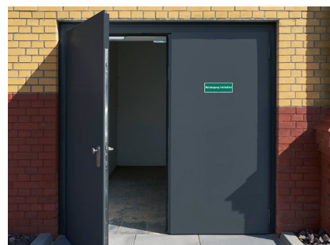
Speziell sind auch die Notausgänge aus den Bürotrakten: Die Sicherheitstüren (Dreipunkt-Mehrfachverriegelung, Selbstverriegelung) sind auch mit Vollpanikfunktion ausgestattet. Von außen schützen die Türen somit die Nutzer vor Einbruch, zugleich sind sie Fluchttür und so von innen nach außen jederzeit in voller Flügelbreite zu öffnen.
