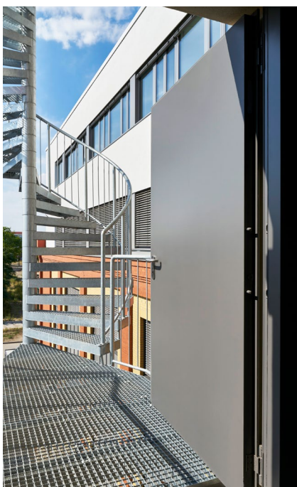
Treppenturm mit Fluchttüren. Die Sicherheitstüren sind mit speziellen Blockzargen ausgestattet.
