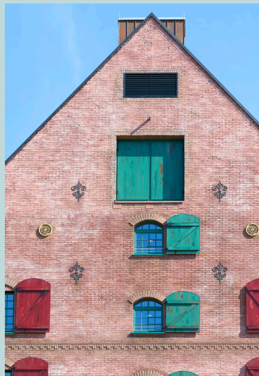
Uniquement pour ceux qui ont le vertige : Les portes ont été installées à une hauteur élevée et même ici, elles s'intègrent parfaitement à l'architecture authentique.
