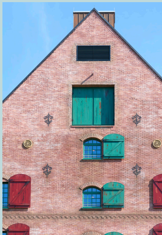
Nur etwas für Schwindelfreie: In luftiger Höhe wurden hier die Türen montiert und fügen sich selbst hier noch bestens in die authentische Architektur ein.
