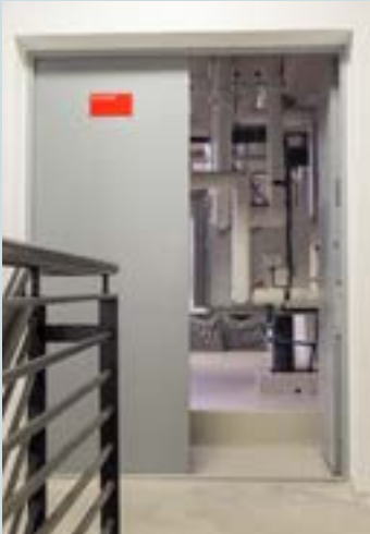
Hier herrscht Funktionalität vor: Technikräume sind mit zuverlässigen Schutztüren ausgestattet.
