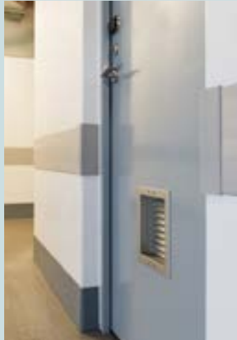
Mehrzwecktüren mit Lüftungsgitter sorgen im Kellergeschoss für Sicherheit.
