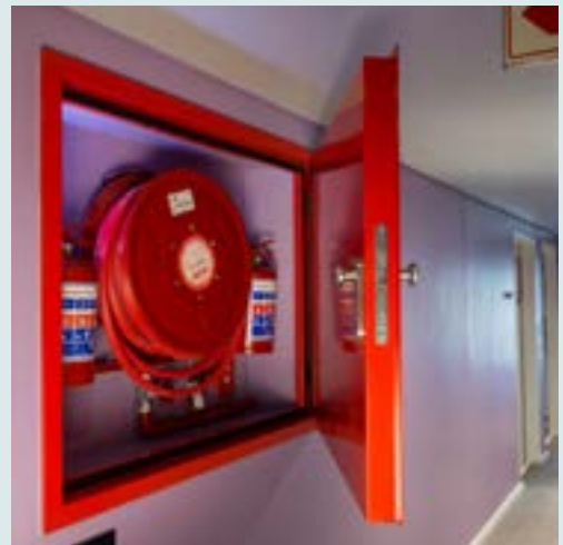
Brandschutzklappe im Radisson-Red.
