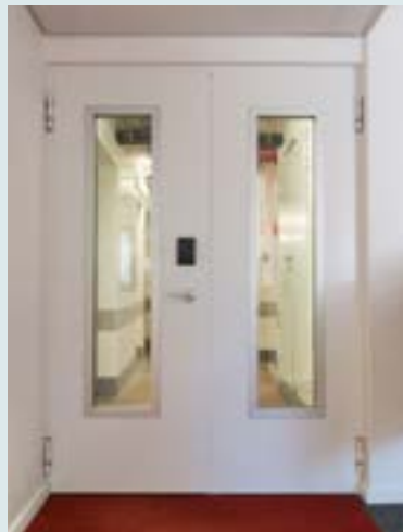
Glaseinlässe in den Brandschutztüren sorgen in den Fluren für gute Sicht.
