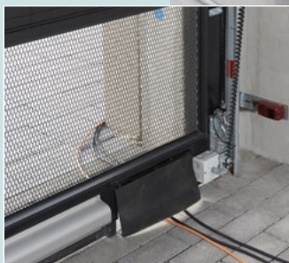
Kunststoffklappe für die Kabeldurchführung bei TV-Übertragungen. Mit Sicherheits-Lichtschranke, die bei der Unterbrechung des Lichtstrahles das Tor sofort stoppt.
