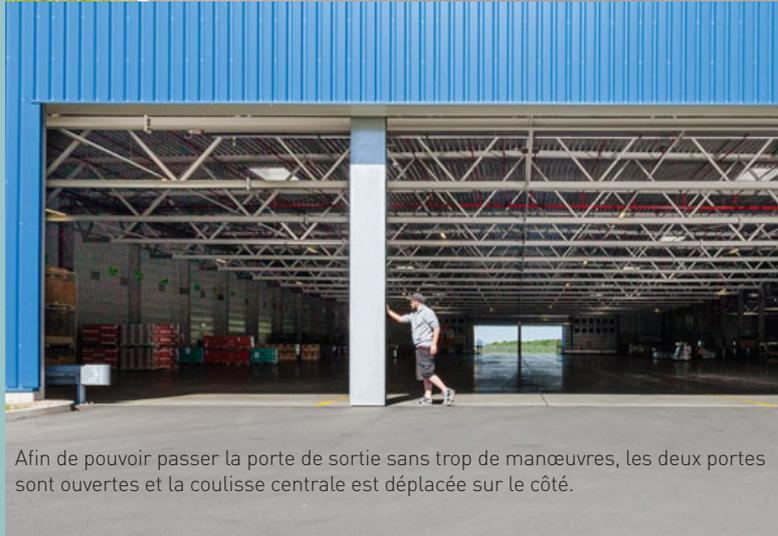
Afin de pouvoir passer la porte de sortie sans trop de manœuvres, les deux portes sont ouvertes et la coulisse centrale est déplacée sur le côté.
