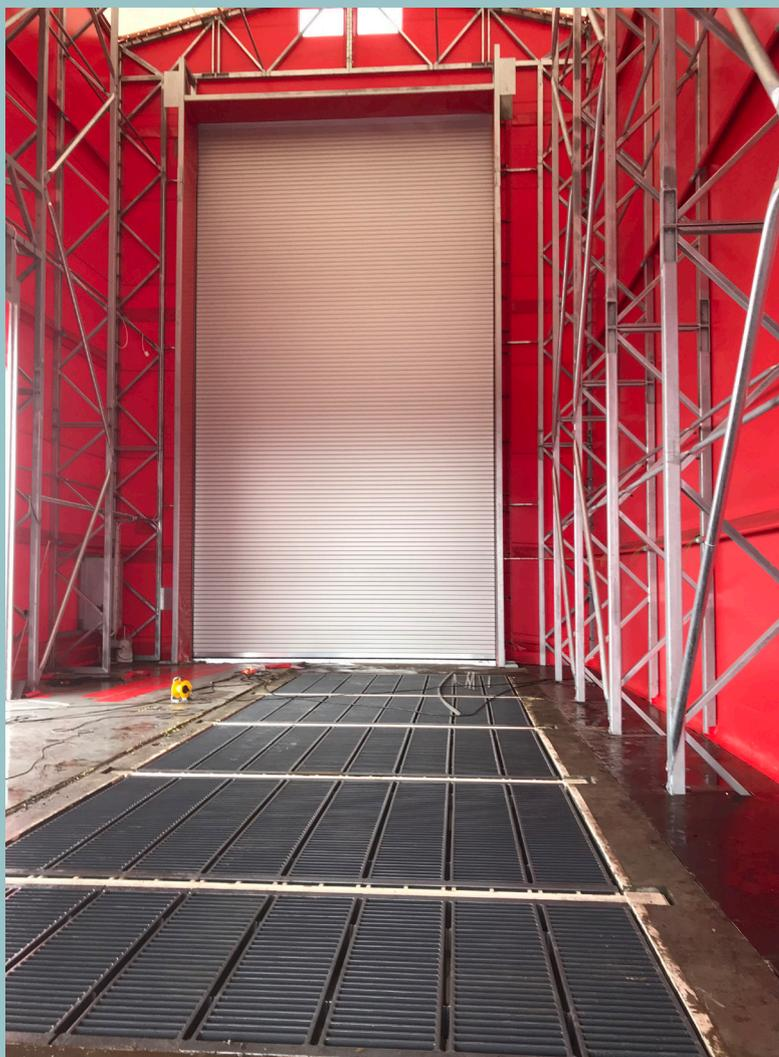
Avec une hauteur de 12,5 mètres, cette porte à enroulement est l'une des plus grandes que Teckentrup ait jamais construites. Elle ferme un entrepôt agricole où les transporteurs de céréales peuvent décharger leurs marchandises dans des silos.
