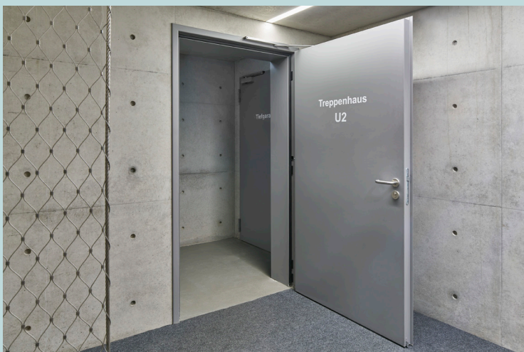
Im Untergeschoss wurde auf Flächenbündigkeit verzichtet – der Optik bei den Türen tut dies keinen Abbruch.
