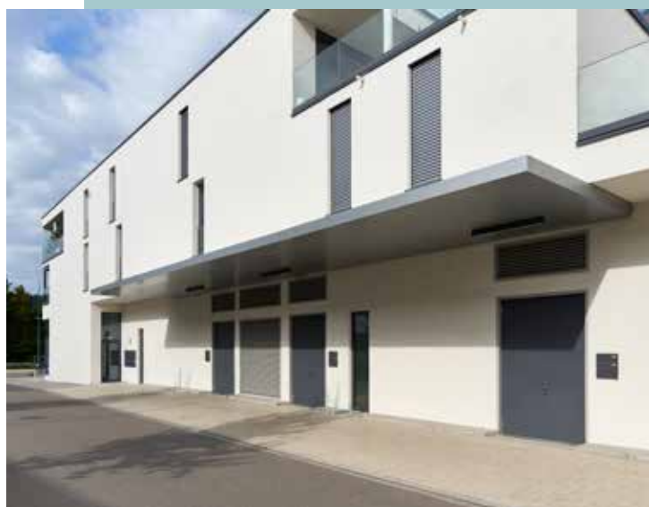
Außentüren zu den Gewerbeeinheiten. Die robusten Stahlelemente passen sich optisch in das Gesamtbild des Komplexes ein und schützen mit der Sicherheitsklasse RC3 vor Einbrüchen.
