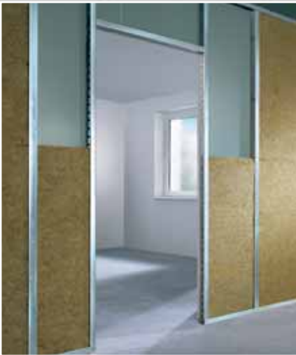
Einsatz der Dämmplatten in die Montagewand.
