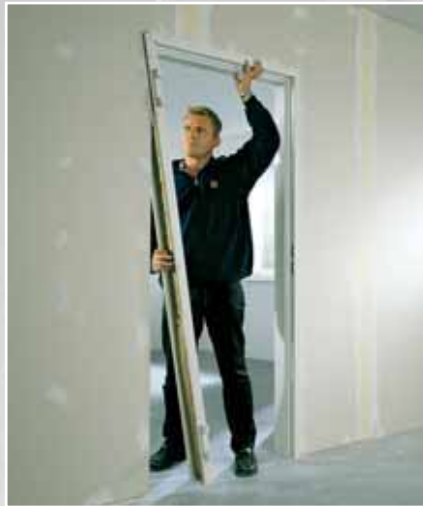
Einbau und Anpassung der mit Isoliermaterial vorgefertigten Schnellbauzarge.
