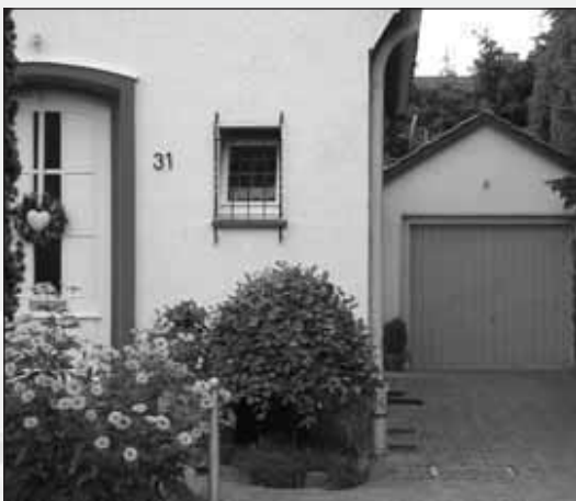
Voor de renovatie
