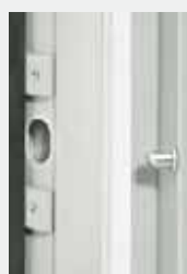
Veiligheidspennen en tochtspleetbegrenzer voorkomen het uittillen van de deur
