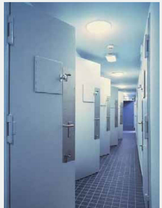
Celdeur met luik voor het zichtvenster.
