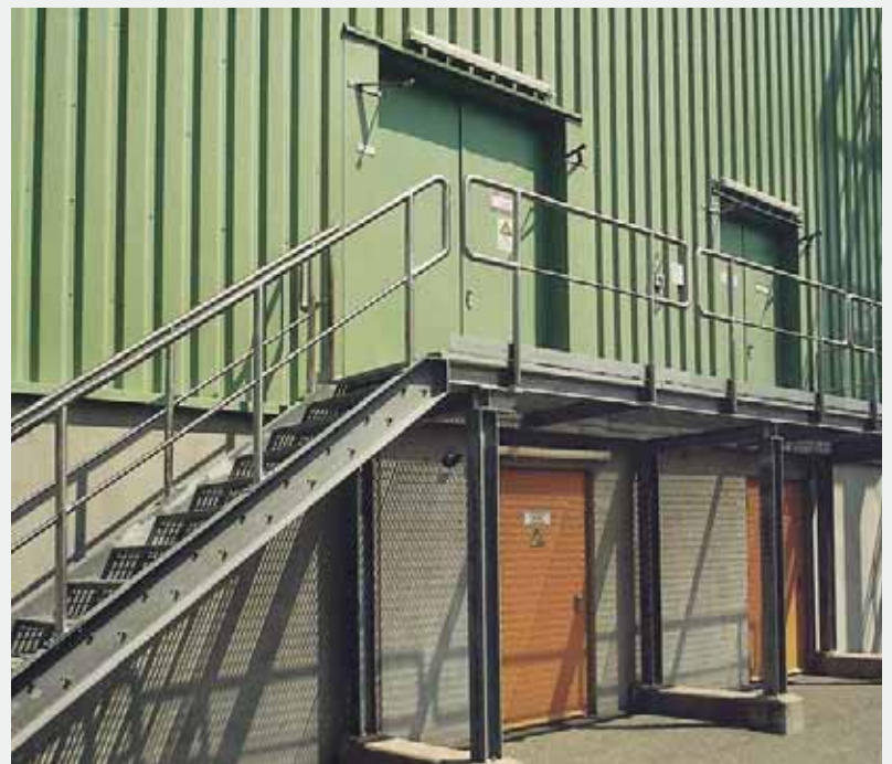
Inbraak- en brandwerende stalen deur, T90-2 „Teckentrup SV“, WK 3.
