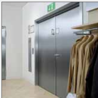
Roestvrijstalen rookwerende deuren
