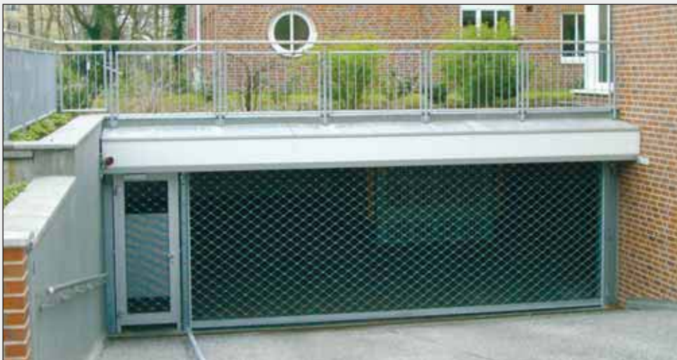
Rolo mreža sa sporednim vratima u podzemnoj garaži.
