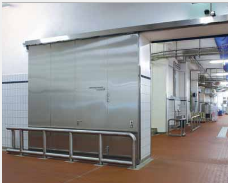
EI 2 30/EI 2 60/EI 2 90 skjutportar, testade och godkända enligt EN 1634, med gångdörr.
