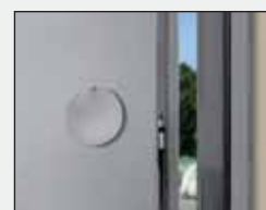
Vrata v mirovanju. Pod pokrovčkom v vratnem krilu se nahaja ventil za napihovanje tesnil.
