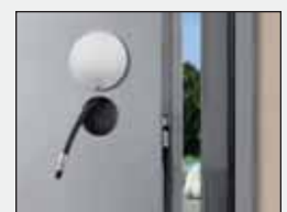
Ob nevarnosti visoke vode se pokrovček odpre in ventil postane viden.
