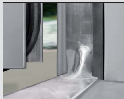
V podlaze se zakotví speciálně tvarovaný nerezový profil.
