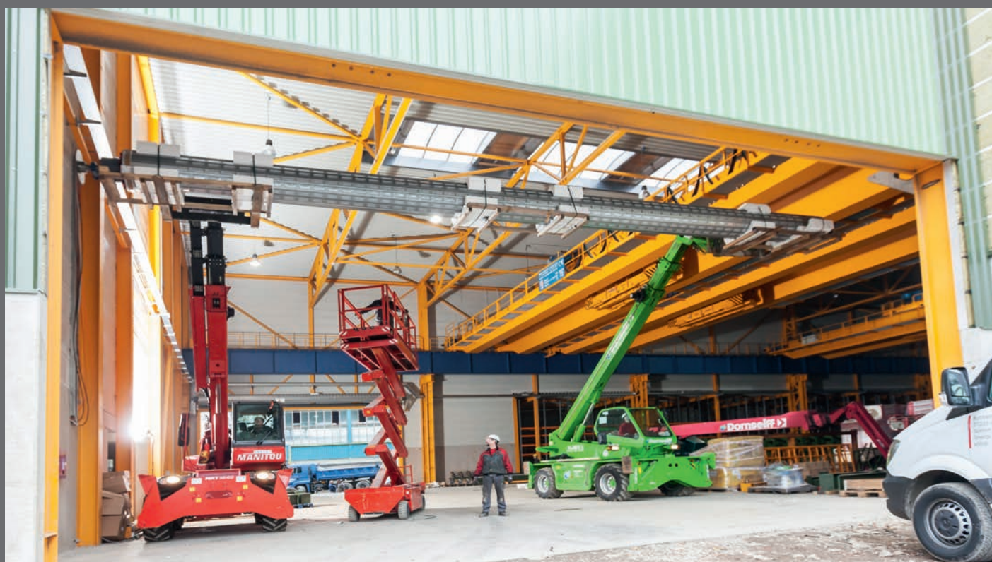
Dachdachte Konzepte von der Entwicklung bis hin zur Montage.
