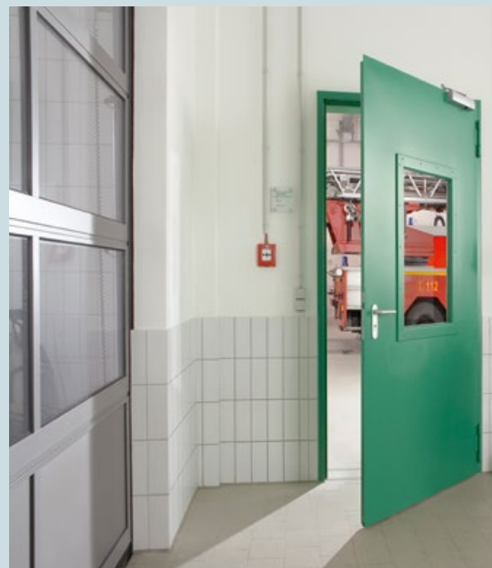
Die Verglasung bietet freie Sicht in die Fahrzeughalle.
