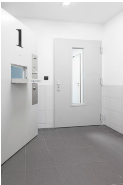
Der Zugang zum Zellentrakt (mit Verglasung) erreicht die Sicherheitsklasse RC 3.
