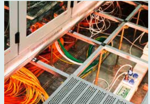
Eine große technische Herausforderung stellt die Bauweise der einzelnen Serverräume (Cages) dar. Hier muss Brandschutz in erhöhten Einbaulagen (sogenannten Doppelböden) in Verbindung mit Leichtbauständerwandkonstruktionen ermöglicht werden. Fotos: © www.lindner-group.com
