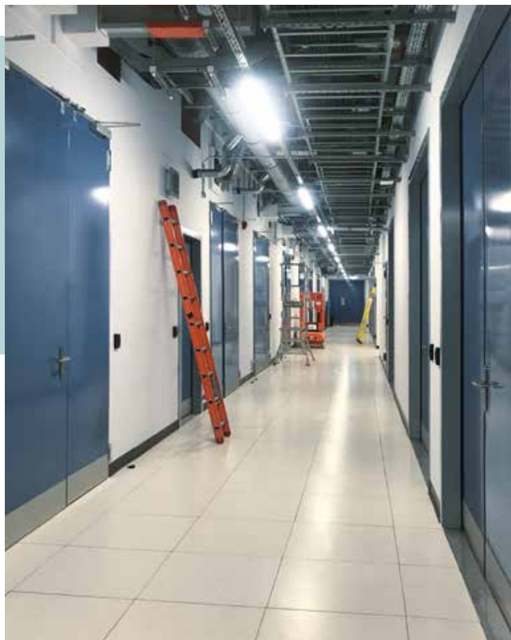
In Rechenzentren werden vor allem 2-flügelige dw 62-Türen in großen Abmessungen (3 x 3 Meter) eingesetzt.
