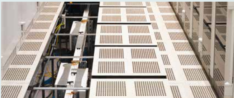
Eine große technische Herausforderung stellt die Bauweise der einzelnen Serverräume (Cages) dar. Hier muss Brandschutz in erhöhten Einbaulagen (sogenannten Doppelböden) in Verbindung mit Leichtbauständerwandkonstruktionen ermöglicht werden. Fotos: © www.lindner-group.com
